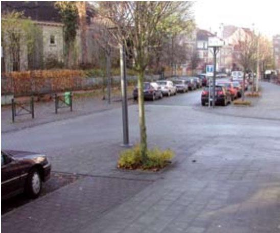
Carrefour sur plateau encadré de plantations et de luminaires.
