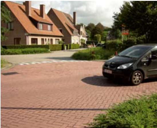
Le plateau est ici complété par des oreilles pour en réduire la largeur. Ces oreilles ont fait l'objet de plantations basses ne masquant pas les piétons ou cyclistes.
