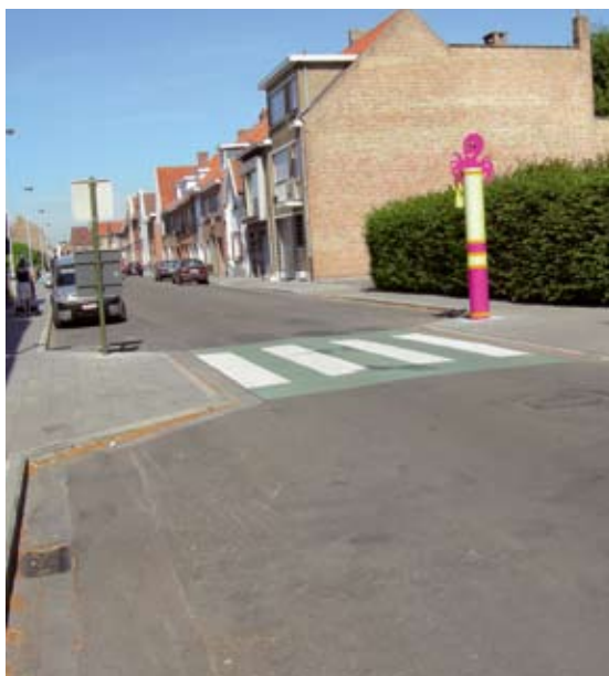
Cette avancée de trottoir aurait pu être plus efficace en étant plus longue en amont du passage.
