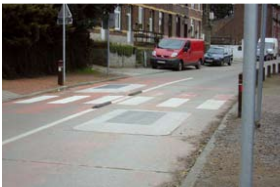
Entrée de zone 30 abords d'école marquée par deux coussins encadrant le passage piétons, à noter les bordures collées pour empêcher les véhicules de slalomer entre les aménagements.
