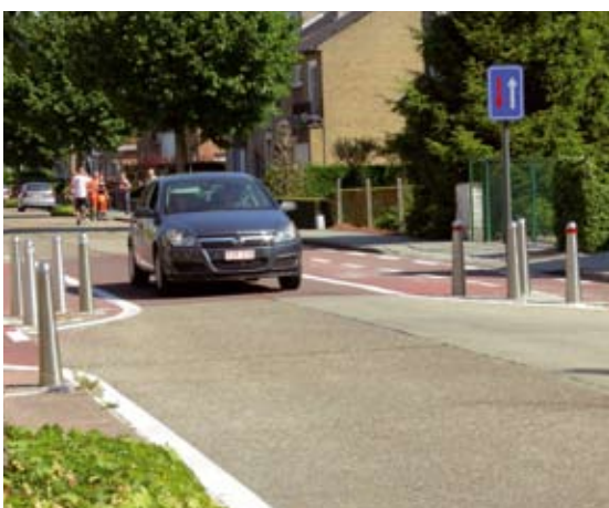
Ici, un rétrécissement par passage alterné réalisé avec un changement de couleur de revêtement et du mobilier urbain. Les vélos peuvent toujours passer sans modifier leur trajectoire ou céder le passage.
