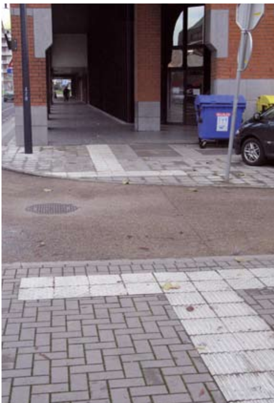
Traversée aménagée pour les PMR, dalles podotactyles, ligne guide et bordures enterrées.
