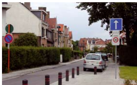
Effet de porte réalisé par une avancée de trottoir, pour être plus visible, le panneau aurait pu être placé près de la bordure.
