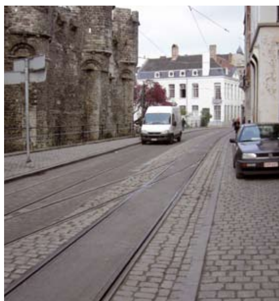
Entre les rails de tram, les pavés ont fait place à un revêtement hydrocarboné, nettement plus confortable pour le cycliste.
