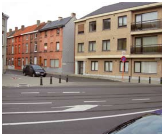
La bordure est bien continue au travers de la voirie, et les potelets empêchent l'accès des voitures au reste du trottoir.
